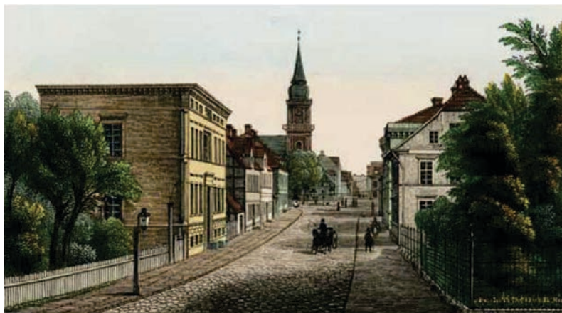
Die Schelfstadt, um 1850 von Norden. Einen zentralen Blickfang der um zwei Plätze gruppierten Häuser bildet die barocke Kirche mit ihrem dreigeschossigen Turm. The Schelfstadt in 1850, viewed from the north. The Baroque church, with its three-story tower, the central focal point of the clustered houses, grouped around two places. Schelfstadt omkring 1850 från norr. Barockkyrkan med ett torn i tre plan är centralt placerad mellan husen.
