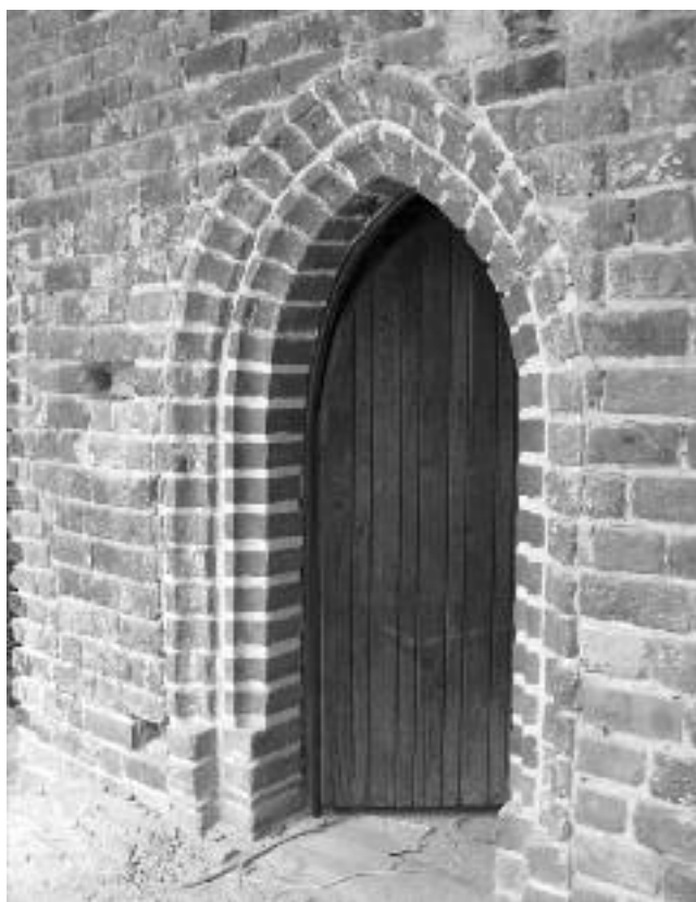
Abb. 15 (oben): Neubrandenburg. Südportal des Nord-südtraktes im ältesten Nordbau (vermutliches Gästehaus), vermauert. Aufnahme 2008 (Foto: Jens Christian Holst, Hoisdorf).
