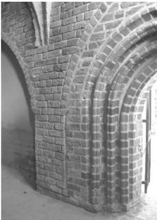
Abb. 10: Neubrandenburg. In die Arkatur des Kreuzganges am Übergang vom Ost- zum Nordflügel nachträglich eingemauertes Portal. Aufnahme 2008 (Foto: Jens Christian Holst, Hoisdorf).
