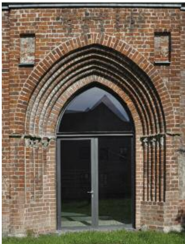
Abb. 14: Rostock, Franziskanerklosterkirche. Westportal (Foto: Leonie Silberer, Heidelberg).
