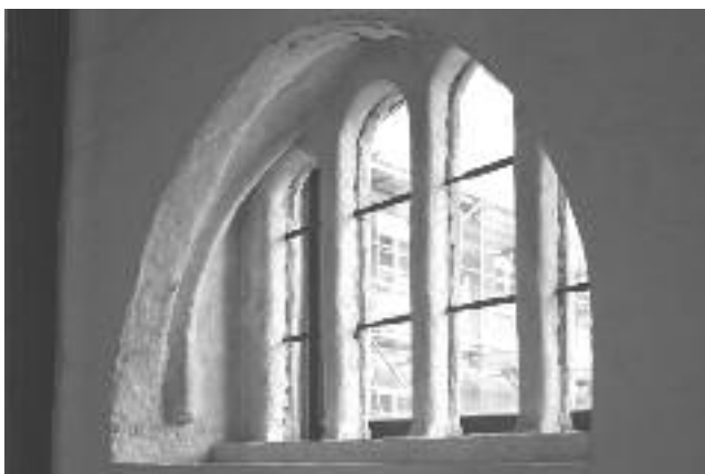
Abb. 9: Neubrandenburg. Nach Abbruch des vormaligen Kreuzganges zu einer Nische reduzierte Kapelle in der Klosterkirchenordmauer, freigelegt. Aufnahme 2012 (Foto: Jens Christian Holst, Hoisdorf).
