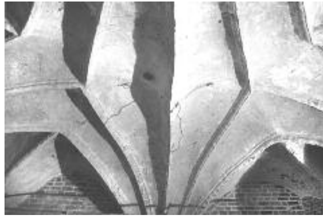
Abb. 19: Neubrandenburg. Ausschnitt eines der figurierten Gewölbe über den Erdgeschossräumen des Nordflügels. Aufnahme 2011 (Foto: Jens Christian Holst, Hoisdorf).
