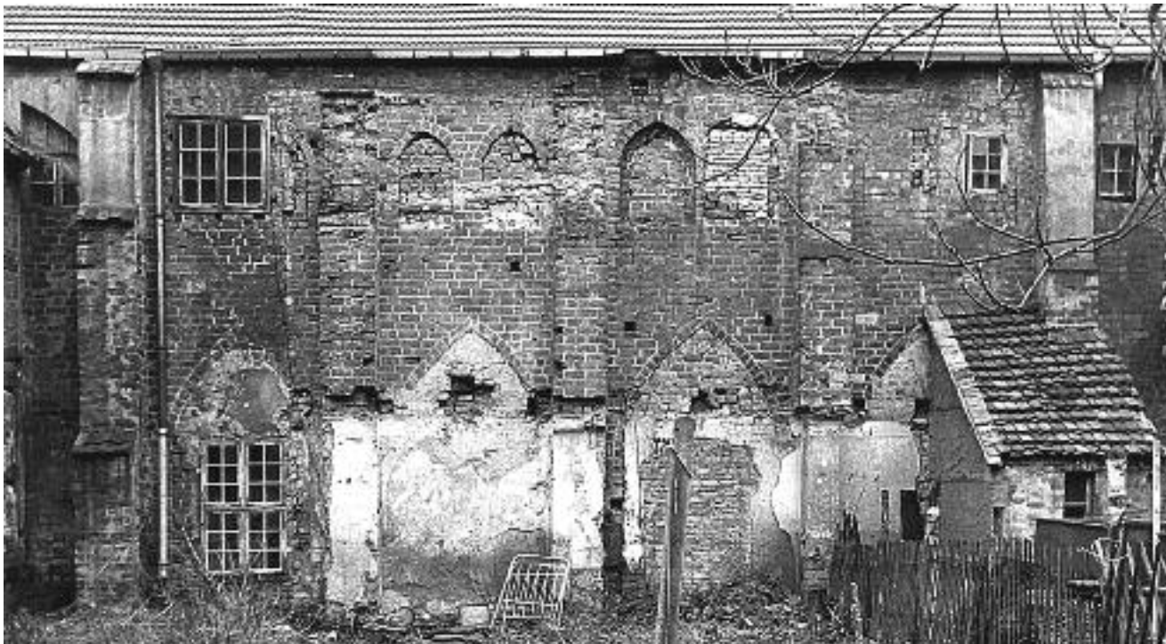
Abb. 20: Neubrandenburg. Hoffassade des Nordflügels. Zustand vor den Umbauten der 1970er Jahre. Noch deutlich erkennbar die ursprünglichen Luken des Dormitoriums über der Arkatur des Kreuzganges (Nachweis: LAKD/AD Bildsammlung Bau- und Kunstdenkmalpflege; Foto: Reinhard Doherr, Neubrandenburg).
