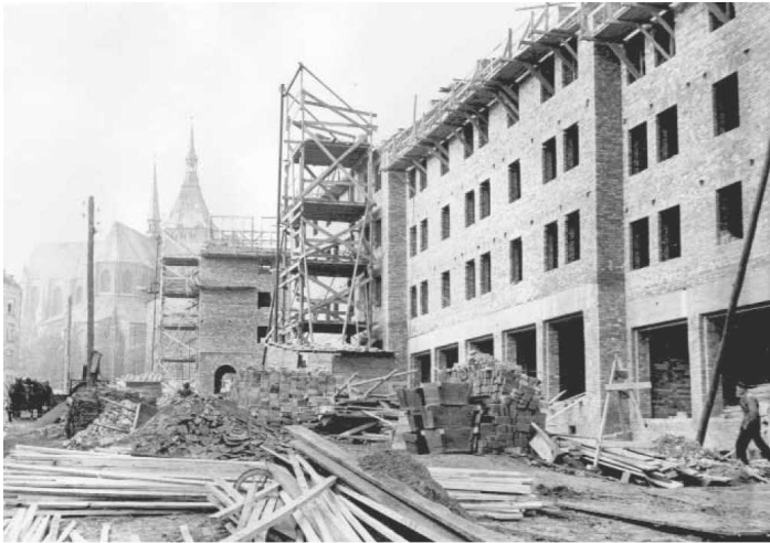
Der Wiederaufbau der Krämerstraße, 1951
